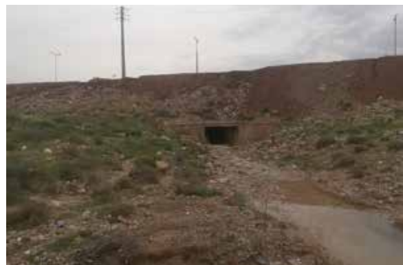
شکل - ۸ : عدم ظرفیت کافی کالورت برای عبور سیل‌های با دوره‌ی بازگشت بالا
