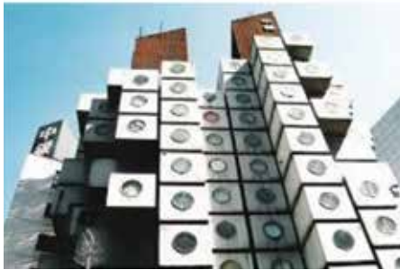
تمویر شماره ۶ : پنجره‌های دایره‌ای در برج کپسولی ناکاگین
